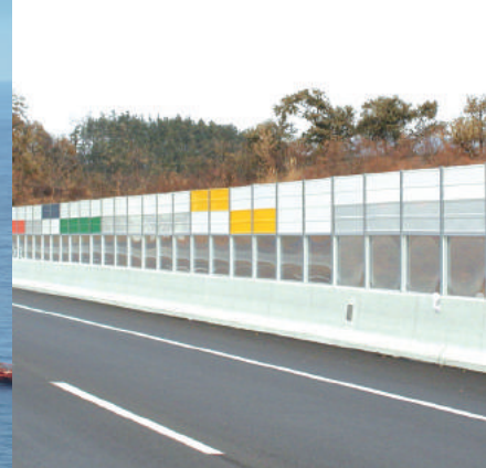
도로공사 CCTV전주, 도로표지판 전주, 가드레일, 방음벽, 차광망, 휀스, 교량점검로
